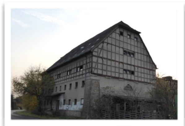
Fachwerkspeicher vor dem Einsturz/Abriss, 2015
